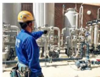
貯水槽設備の点検の様子
